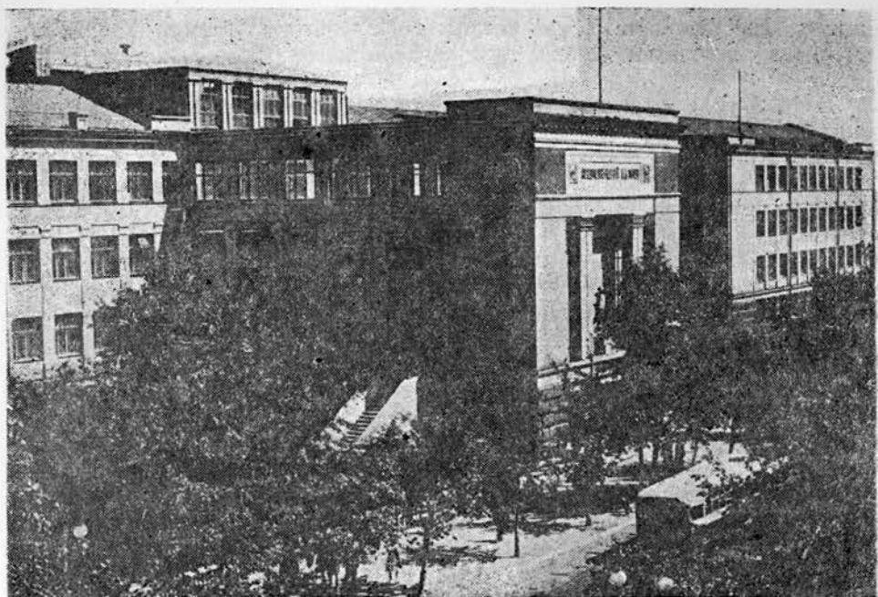
Главный учебный корпус Сибирского лесотехнического института.
