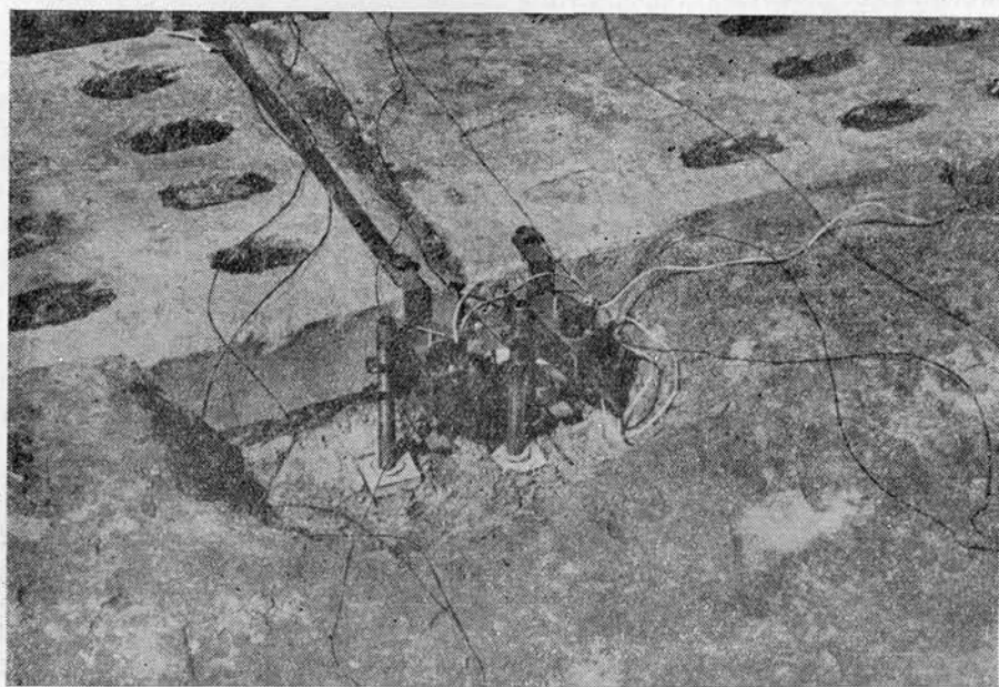
Рис. 3. Установка вибрографов для записи просадок и взаимного смещения плит.
