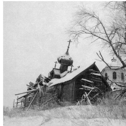
Рис. 2. Обрушение верха церкви Богоявления Господня в пос. Палтога
