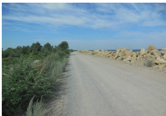
Рис. 3. Вал из ракушечника, защищающий прибрежные территории от нагонной волны
